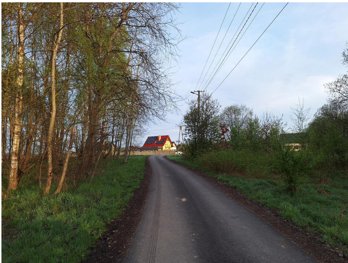
Wykonanie nakładki asfaltowej ul. Nowowiejska w miejscowości Okleśna - 53 125,00 złotych
