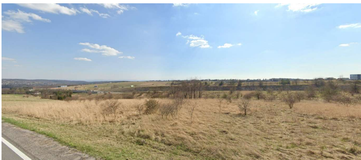
Zdjęcie fragmentu obszaru objętego planem miejscowym od strony miejscowości Rudno, gm. Krzeszowice, z drugiej strony autostrady A4, w kierunku południowo-wschodnim; skrajnie po prawej widoczny budenek serwerowni, na pierwszym planie wykop gdzie biegnie autostrada, po prawej widoczne znaczne zniżenie terenu
